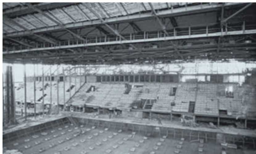
СТРОИТЕЛЬСТВО ПЛАВАТЕЛЬНОГО БАССЕЙНА СПОРТКОМПЛЕКСА «ОЛИМПИЙСКИЙ» НА ПРОСПЕКТЕ МИРА, АВГУСТ 1979 ГОДА
